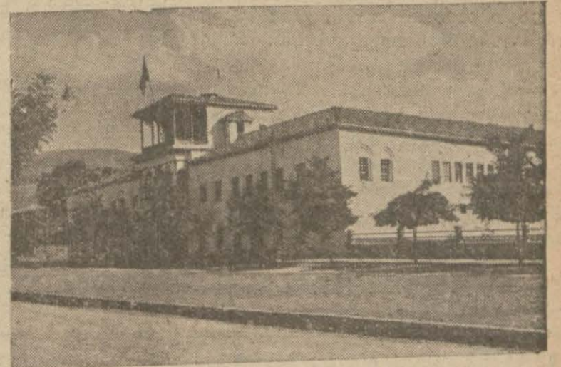
Malatya lise binası
